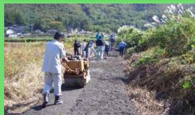
未舗装の農道をアスファルトで舗装
