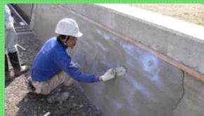
老朽化した水路壁のコーティング
