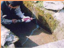
水路のひび割れ補修
