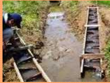
水田魚道の設置
