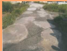
農道の窪みの補修
