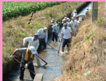
水路の泥上げ
